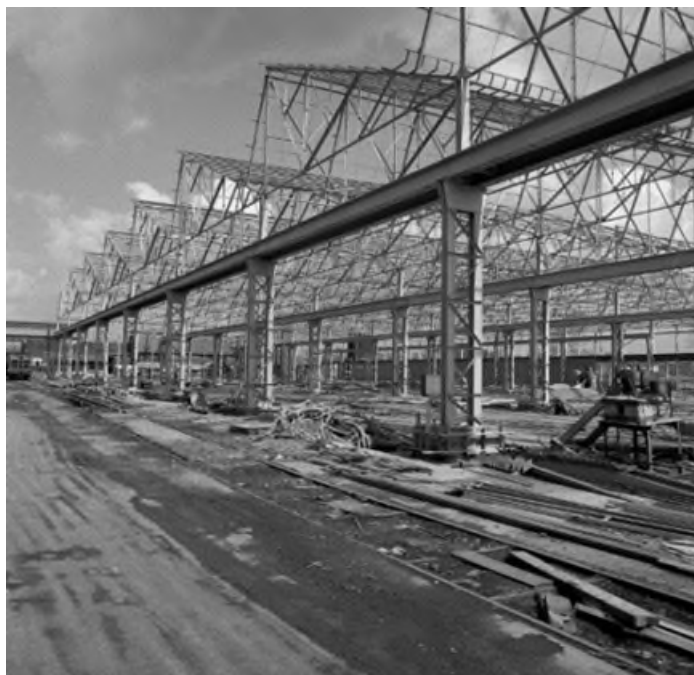
Construction d'un nouveau hall pour l'atelier de Cuesmes en 1965 (Réf. Z09944B)
