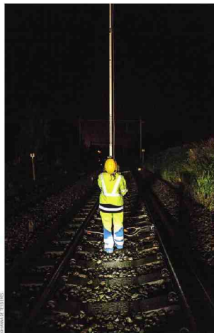
La "mise à la terre" est une opération délicate qui requiert de l'agilité. Manie d'une longue perche, Pearle tente d'attraper le câble en hauteur.
